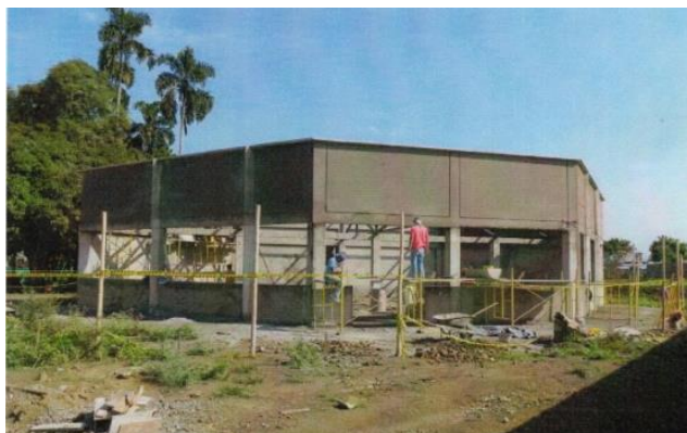
Foto 11. Contrato de Obra 139, Construcción y dotación de Cafetería Central y 10 aulas
